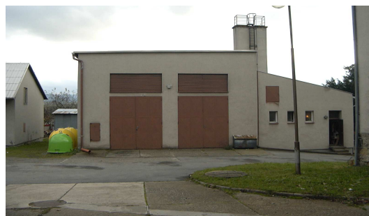
Kotelna s uhelnou
