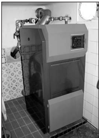
Moderní automatický kotel na dřevní pelety.
