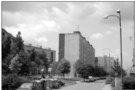
Město Hranice je přirozeným centrem regionu. Typická panelová výstavba, kterou lze najít ve všech větších městech.
