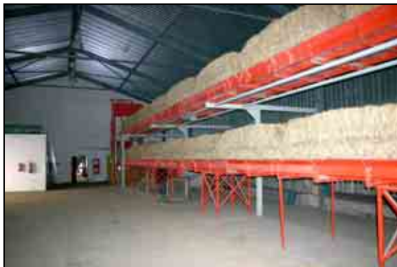
Obrázek 10 - Pohled na zásobník slámových balíků pro zásobování kotle v obecní výtopně v Roštíně.
