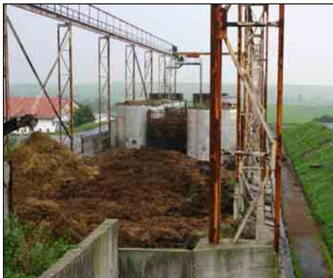
Obrázek 5 - Pohled na skladiště chlévkové mrvy v ZD Luha v Jindřichově. V pozadí jsou ocelové zvony v nichž dochází k fermentaci materiálu a vznikající bioplyn je jímán do nedalekých zásobníků.
